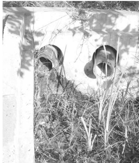
Figura 4. Detalle salida dren.
